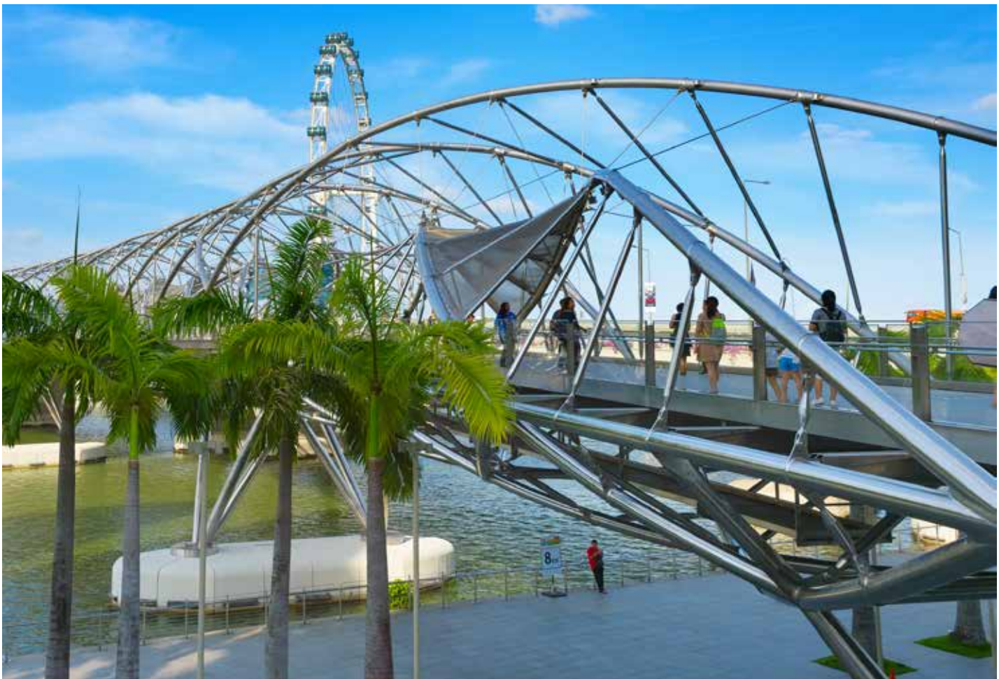
De Helix Bridge in Singapore is gemaakt uit 650 ton Duplex stainless steel en 1000 ton Carbon steel
