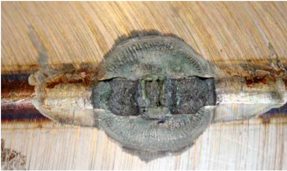
Foto 2: Microbiologisch geïnduceerde corrosie op een roestvast stalen plaatmateriaal 304 (3 mm wanddikte) binnen een periode van een jaar.
