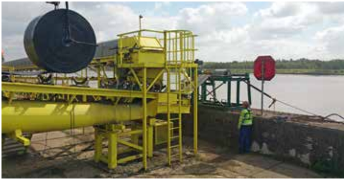
Montage transportband Argex Burcht.
